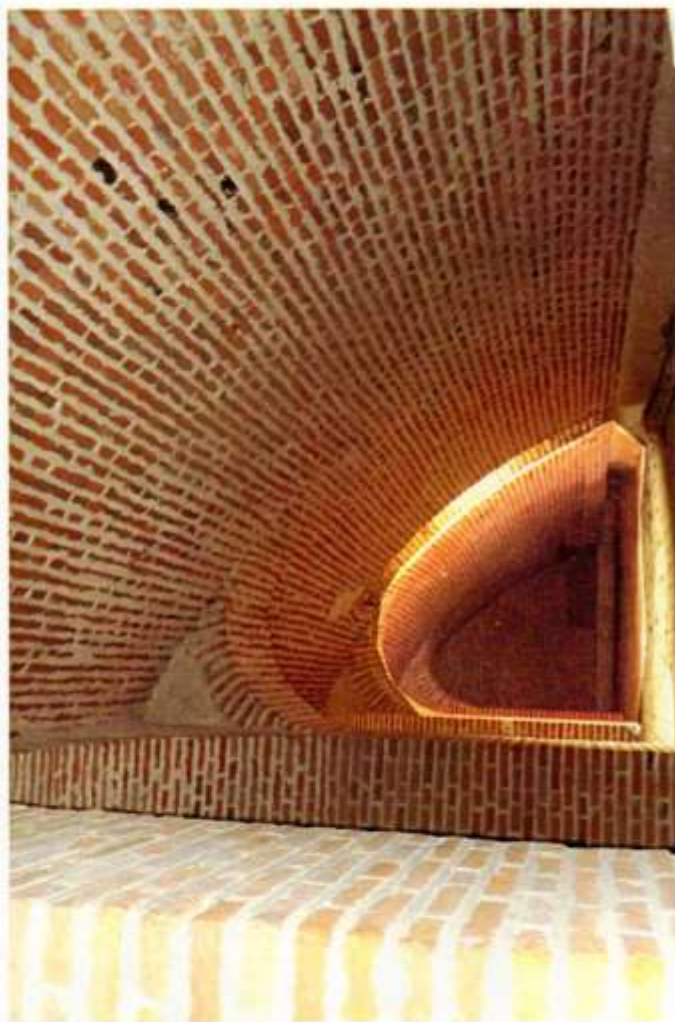
Voûte du grenier, formant charpente
