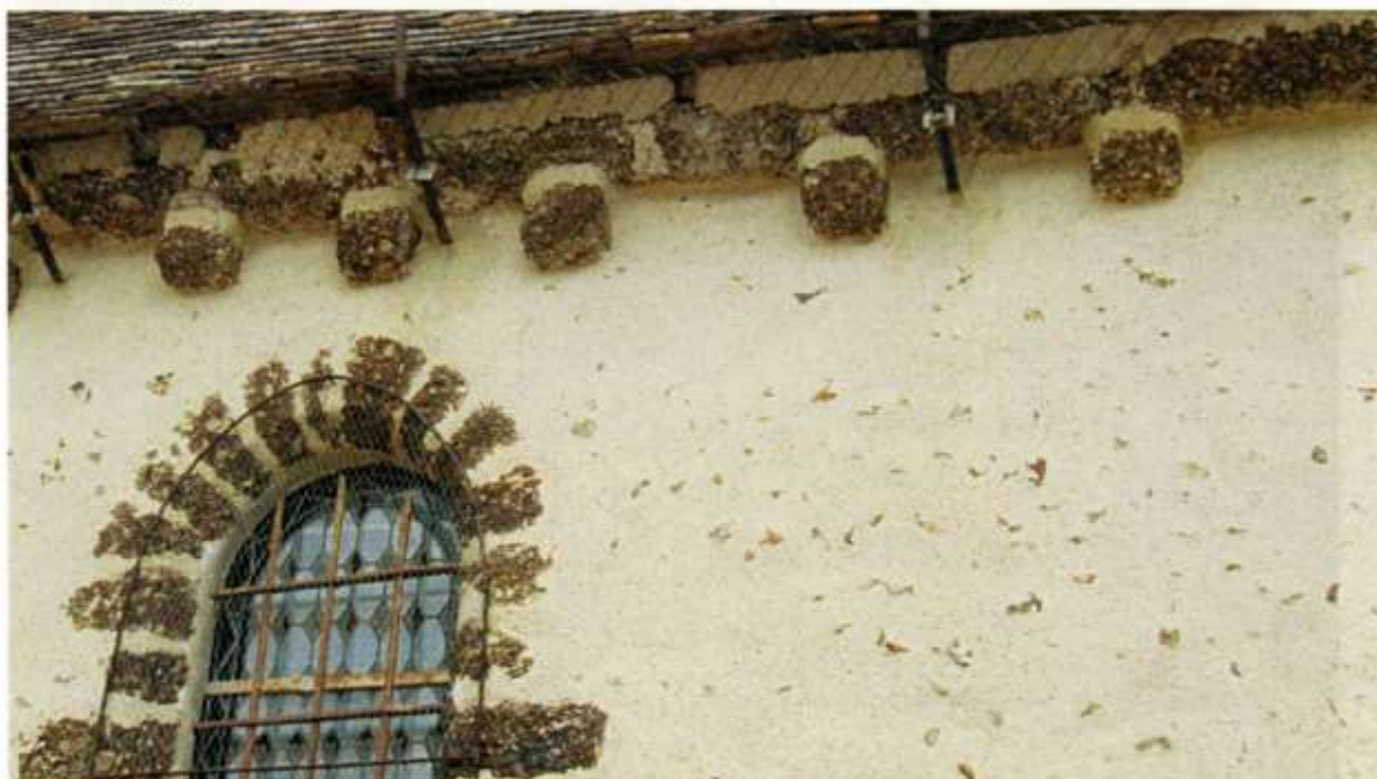
Fenêtre romane,corniche et modillons en grison
